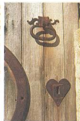
Les volets sont souvent en bois plein, à traverse haute et lames verticales.
