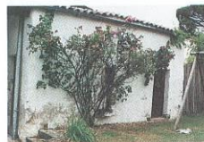
Un rosier habille cette façade très simple.
