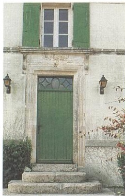
L'imposte vitrée éclaire le couloir. Les menuiseries sont un élément important de la composition des façades charentaises, souvent très simples. Les ouvertures sont presque toutes superposées et plus petites aux étages.
