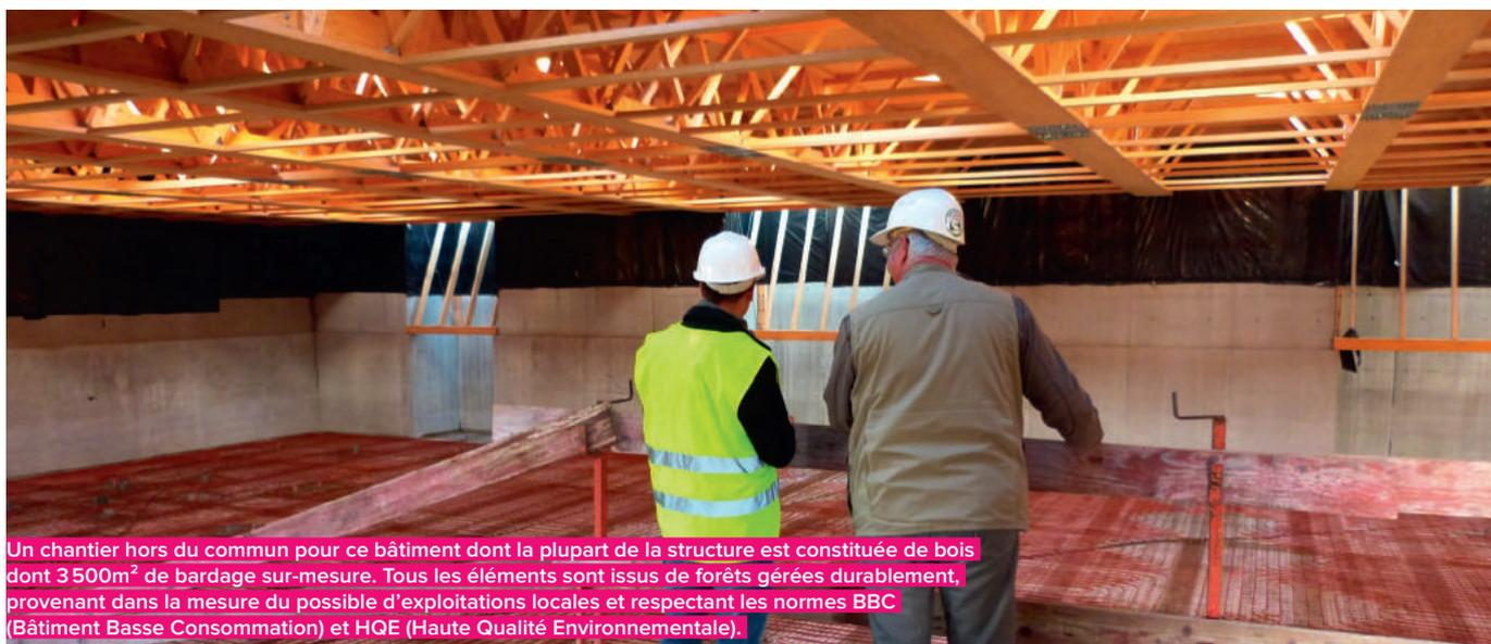
Un chantier hors du commun pour ce bâtiment dont la plupart de la structure est constituée de bois dont 3 500m<sup>2</sup> de bardage sur-mesure. Tous les éléments sont issus de forêts gérées durablement, provenant dans la mesure du possible d'exploitations locales et respectant les normes BBC (Bâtiment Basse Consommation) et HQE (Haute Qualité Environnementale).
