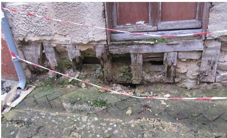
L'absence (ou l'enfouissement) du soubassement maçonné du pan de bois soumet la charpente aux dégradations dues à l'humidité du sol et aux rejaillissements d'eau de pluie.
