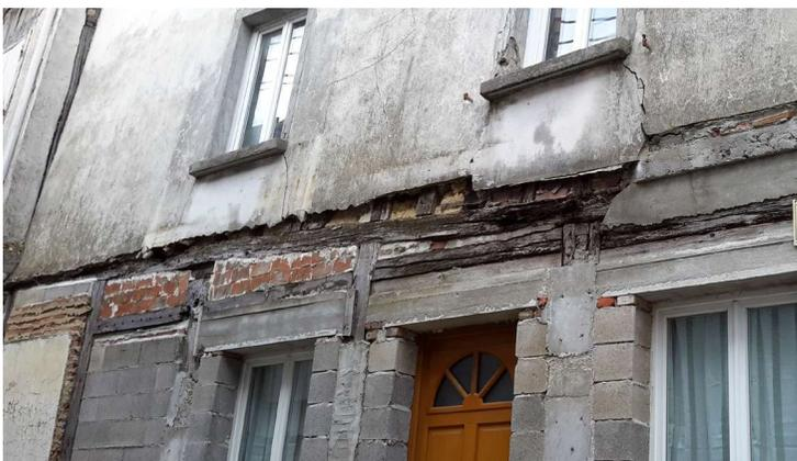
Le remplacement d'une partie du pan de bois par de la maçonnerie, et l'enduit ciment sur la partie haute mettent en péril toute la construction.
