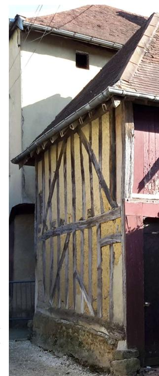
Pan de bois apparent à réparer ponctuellement (charpente et remplissage en torchis); enduit de protection du torchis à refaire.
