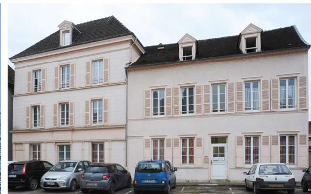
Pan de bois enduit avec modénatures de style Classique en bois (bandeaux, corniches, pilastres) et joints «façon pierre».
