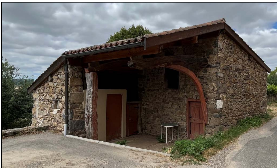
Vue sur les travaux entrepris récemment
