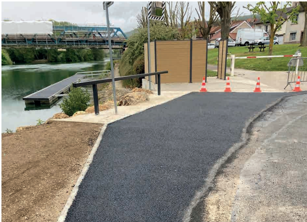
Aménagement de local poubelles
