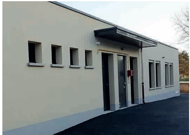
Construction de la nouvelle cantine
