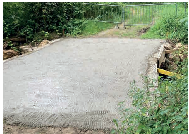
Rénovation complète du petit pont du ru de Brunet
