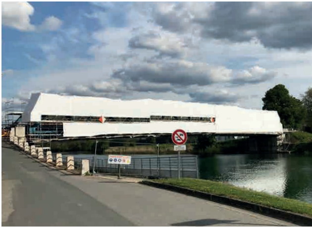
Rénovation du pont
