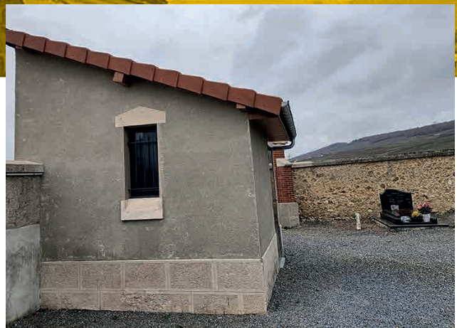
Réfection complète intérieur/extérieur de la chambre funéraire.
