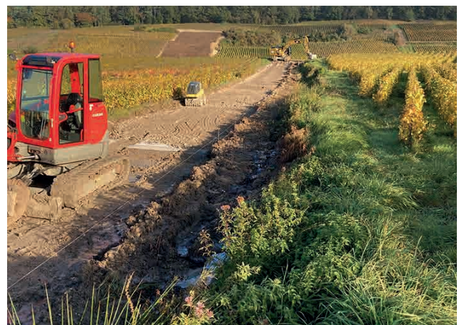
Curage des fossés
