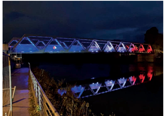
Mise en lumière du pont
