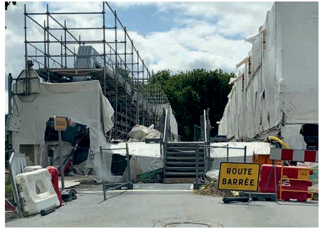
Rénovation du pont
