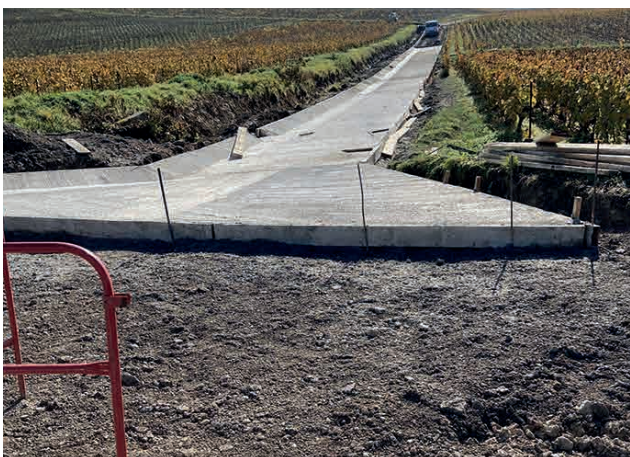
Création d'un chemin béton
