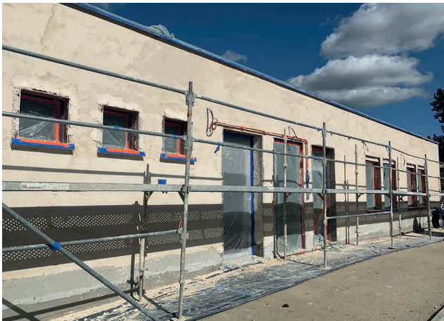
Construction de la nouvelle cantine
