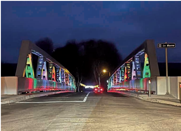
Mise en lumière du pont
