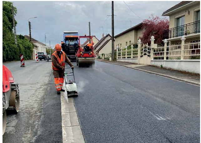
Réalisation de la place rue Georges Clémenceau
