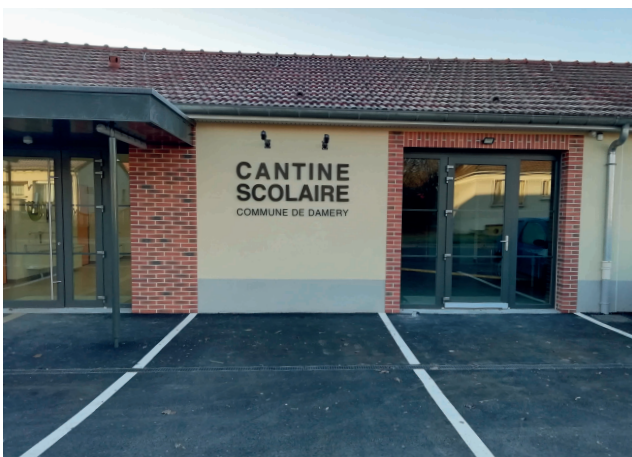
Construction de la nouvelle cantine
