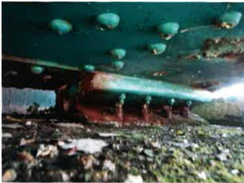
Corrosion importante des platines d'appareil d'appui sur culée rive gauche
