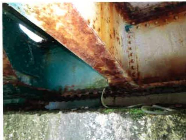
Corrosion des semelles de poutres principales et pièces de pont (côté amont)
