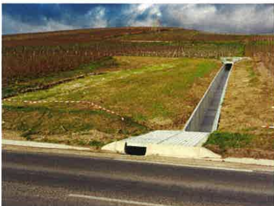
Descente d'eau au chemin Momignons.
