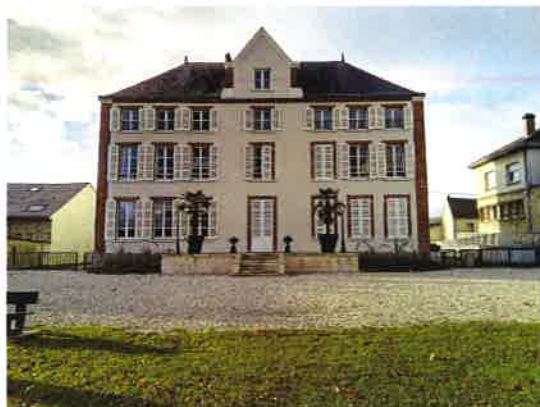
Fin des travaux de la Mairie.
