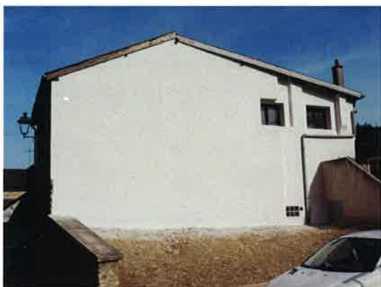
Fin des travaux au presbytère.
