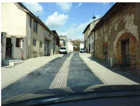
Fin des travaux rue A. Maginot
