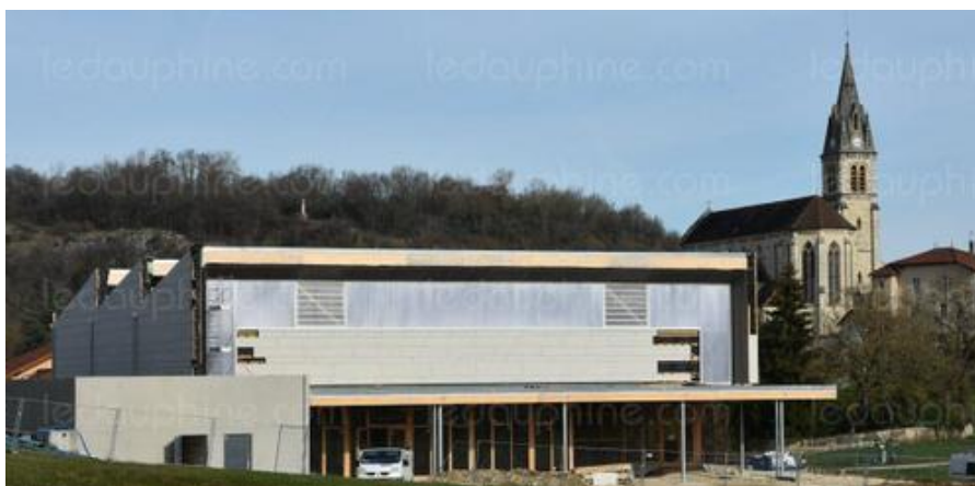
La nouvelle salle est construite dans le hameau de Creys.
