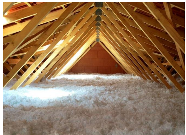
Isolation des combles perdus avec de la ouate de cellulose
