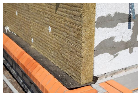
Isolation par l'extérieur avec de la laine de roche
