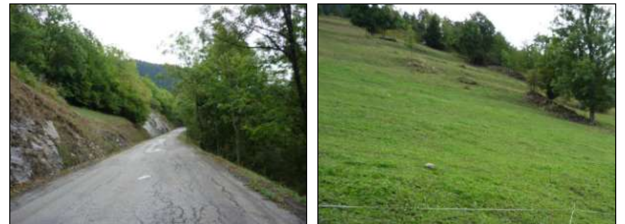
Figure 7 : Fissuration importante de la RD 88 et bourrelets marqués en aval du réservoir [Source : IMS RN ]
