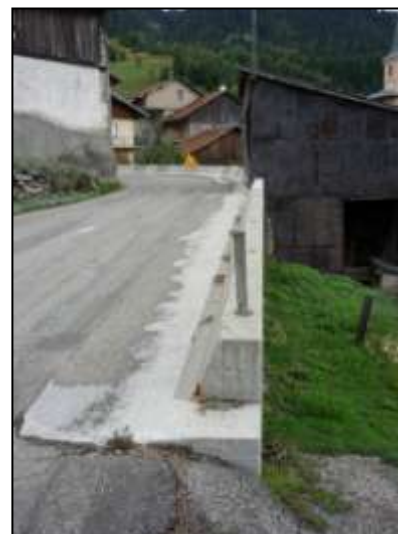
Figure 1 : Mur de confortement à l'entrée du village [Source : IMS RN ]
