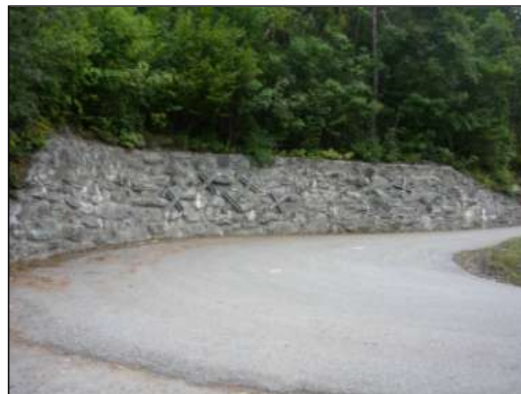
Figure 2 : Enrochement le long de la RD 88 [Source : IMS RN ]
