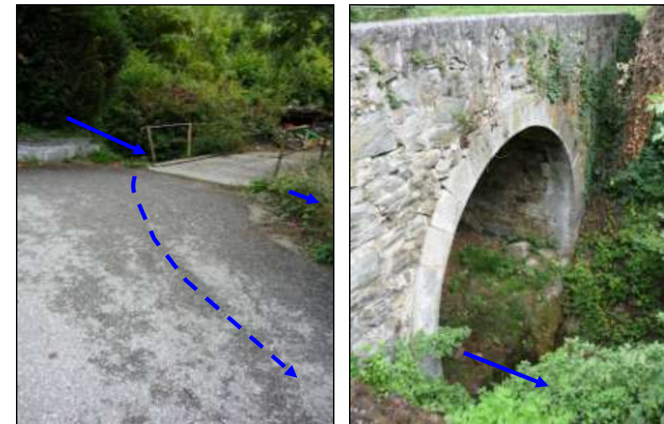
Figure 2 : Passerelle et pont sur le Nantet [Source : IMS RN ]
