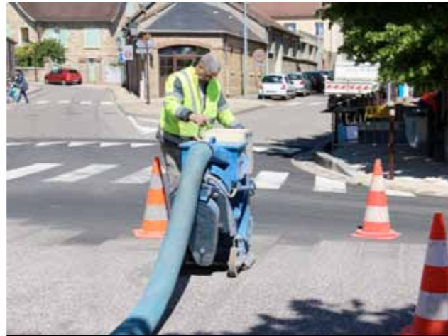
Le grenailage des deux plateaux surélevés et du parking du Jeu de Paume ont été effectués. Le changement de couleur ainsi obtenu des plateaux surélevés par rapport à la chaussée, invite les automobilistes à plus de prudence.
