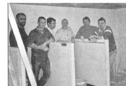
Rénovation de la salle de propreté. Quelques parents bénévoles pour des travaux d'embellissement.
