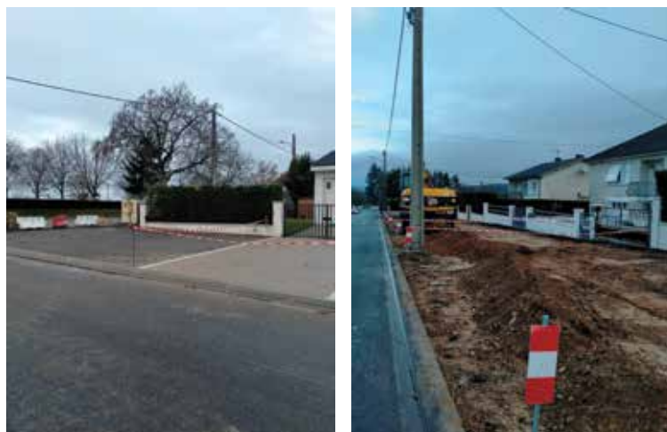
En cours de travaux : Rue de la Camus
