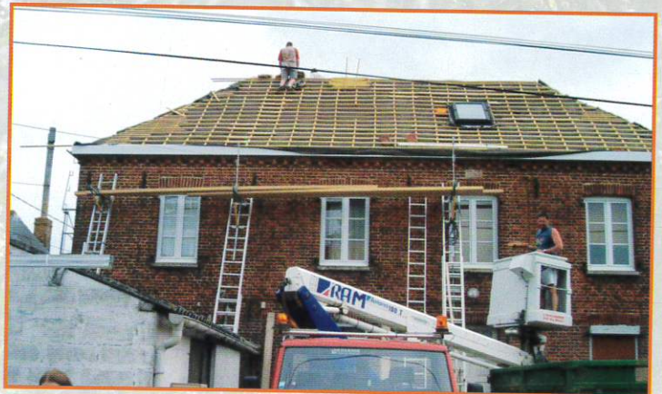
Toiture Presbytère de Crecques
