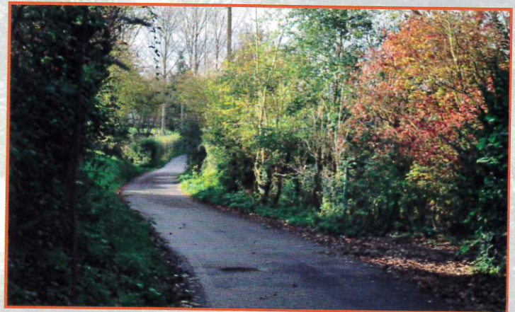
Réfection du chemin des ruelles
