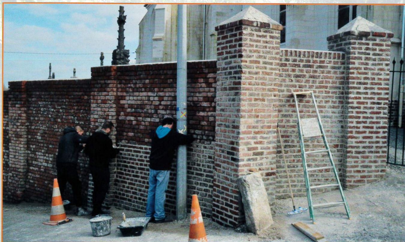
Sablage et rejointoiement du mur du cimetière (A.P.R.T.)
