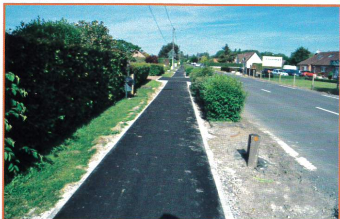
Goudronnage de l'accotement piétonnier
