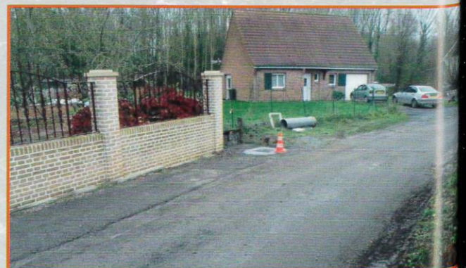
Assainissement pluvial rue de la Barre
