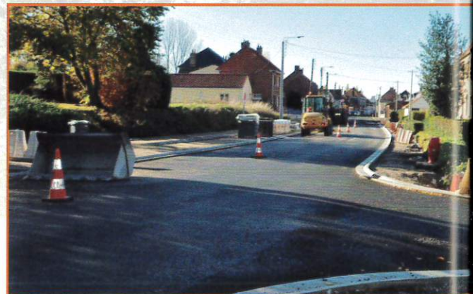
Rénovation de la Grand'rue à l'entrée de Mametz Réfection de la chaussée, création de trottoir remplacement du réseau d'eaux pluviales
