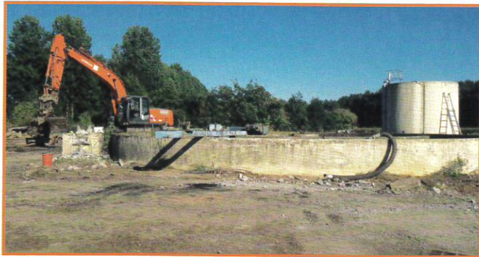
Démolition ancienne station d'épuration
