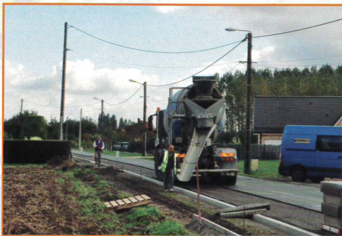
Trottoir rue du choquant 2ème partie
