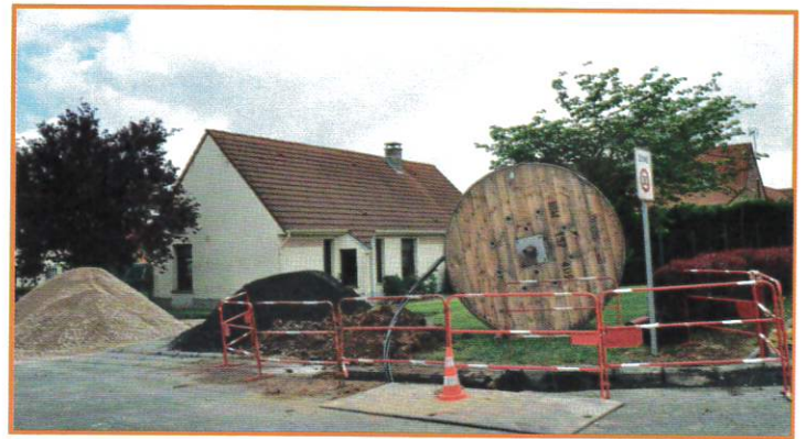
Renforcement du réseau électrique Mamez centre pour les commerces
