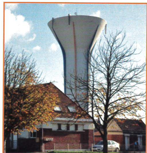
Remise en état du château d'eau
