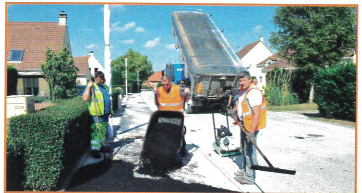
Rénovation complète de la rue de Bruchine
