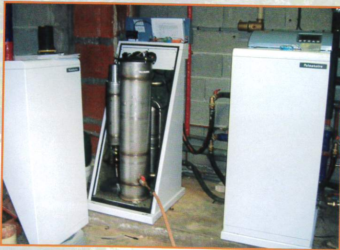
Remplacement des chaudières de l'école
