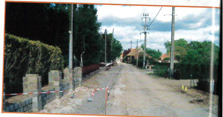
Réfection complète du chemin des Grands Rietz
