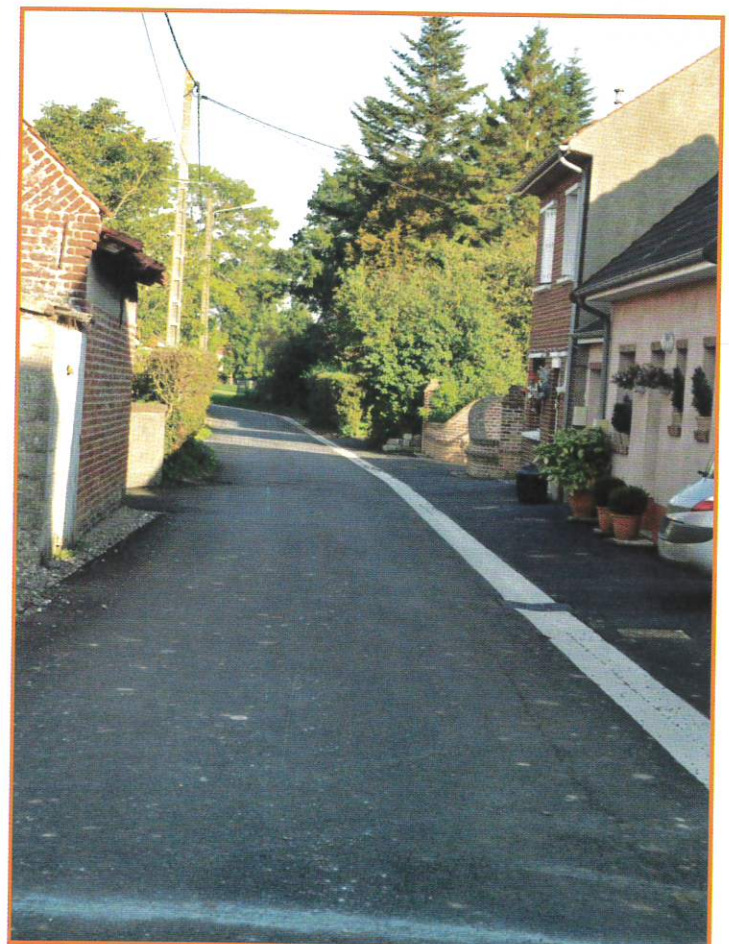
Rénovation complète de la rue de la chapelle
