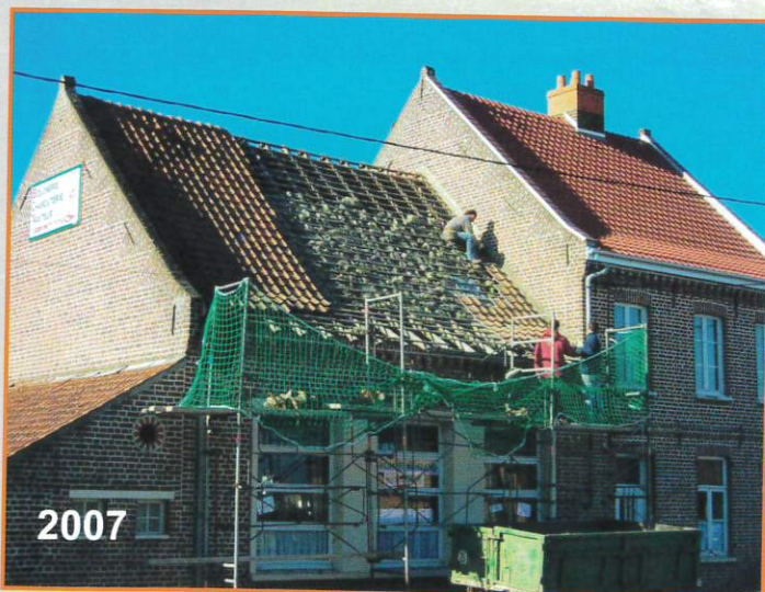
Réfection de la toiture de la mairie actuelle
