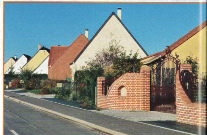
Trottoir rue de la place
