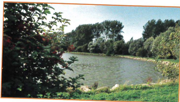
Empierrement des berges de la Sauvagine
