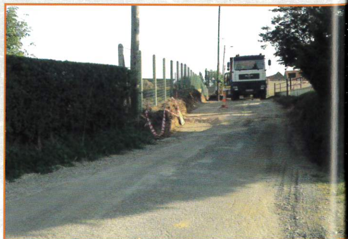
Élargissement du chemin des charbonniers
