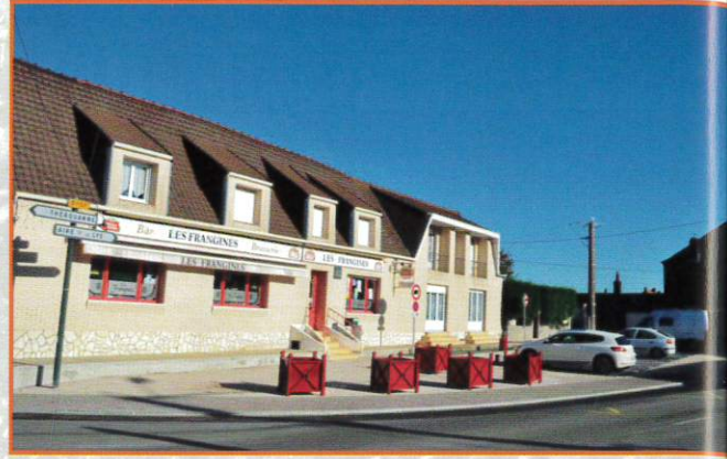
Rénovation de la place des Frangines
