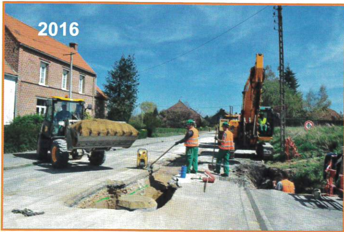
Remplacement du réseau eaux usées Grand'rue
