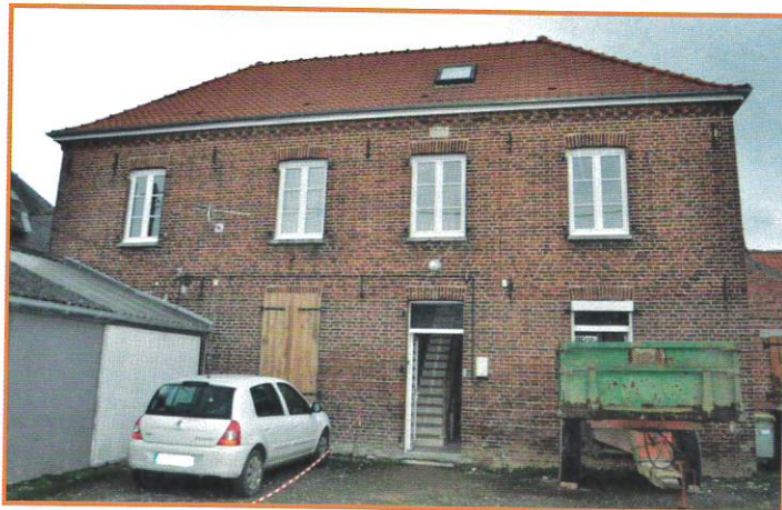
Rénovation des logements du presbytère
