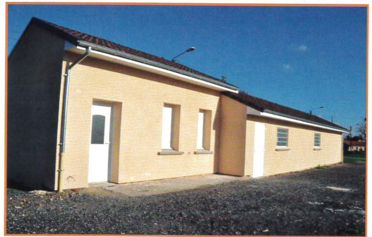
Rénovation du bâtiment des carabiniers de Marthes
