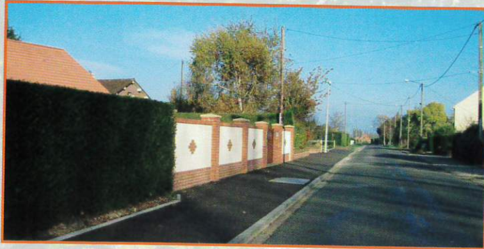
Trottoir rue du Choquart 1ère tranche
