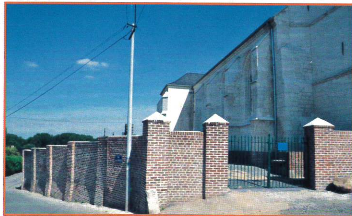
Rénovation mur du cimetière - pavage - réseau pluvial
