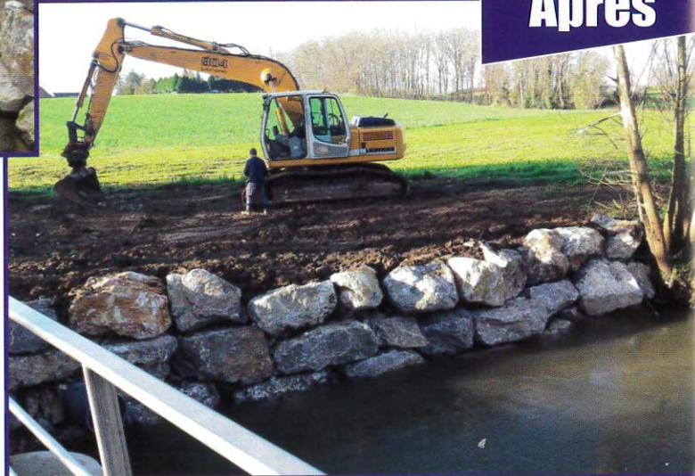
Suite aux fortes pluies de l'automne, les berges de la Lys au droit du Pont de la Sûre se sont effondrées entraînant la rampe béton dans la rivière et mettant en péril le pont. Il était impératif d'agir vite et de stabiliser les berges par la mise en place d'enrochement.
