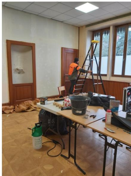
Au regard de la vétusté de l'ex-salle du conseil à l'ancienne mairie, un nécessaire rafraîchissement a été réalisé. Les travaux ont été exécutés par les employés communaux (retrait des anciennes tapisseries, lessivage, ponçage, colmatage des murs et des menuiseries, réalisation des peintures).
