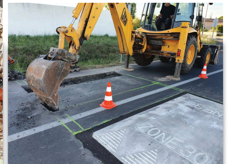
Les nouveaux « coussins lyonnais » ont été encastrés dans la chaussée en amont du rond point de la route de St Félix, ce qui réduit considérablement la vitesse des véhicules à l'entrée du village.
