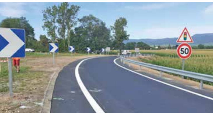
Des aménagements de sécurité sur l'échangeur de Guémar pour 600 000 €.
