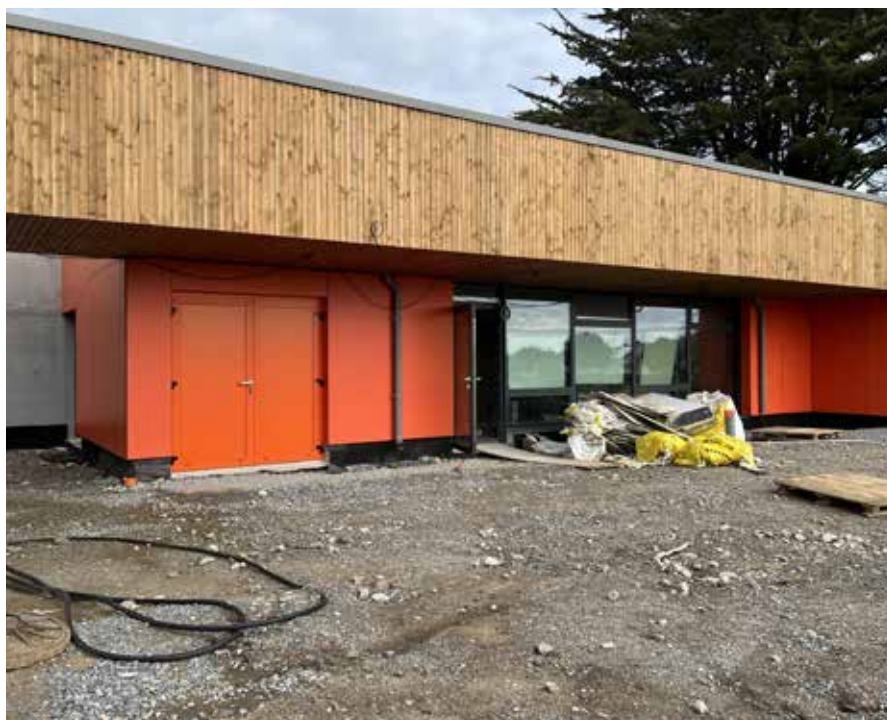
La micro-crèche en construction.
