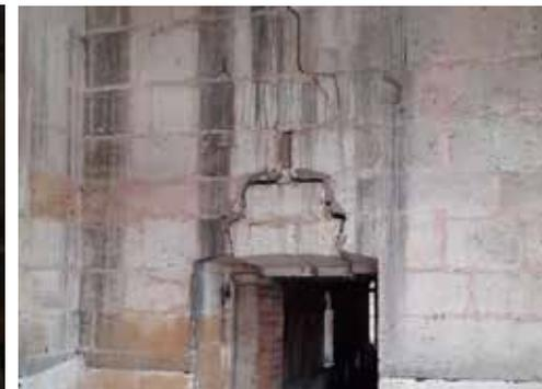
R+3 - fissuration avec déplacement des claveaux
