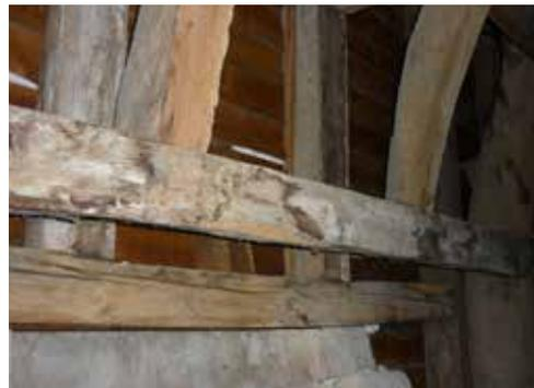
R+3 - Infiltrations sous toiture
