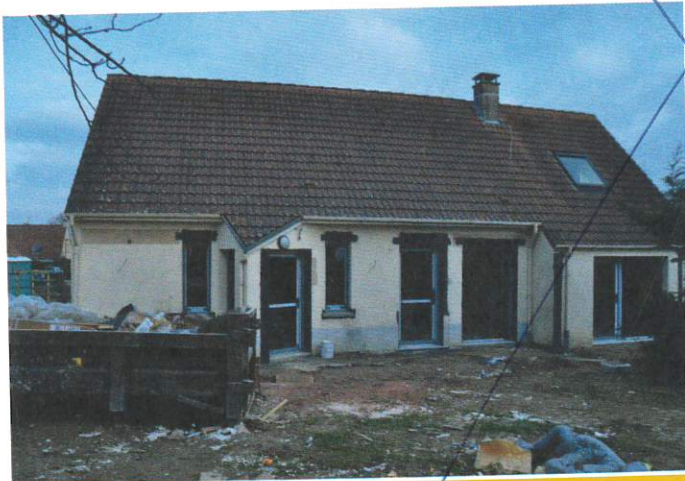
Remplacement des portes et fenêtres
