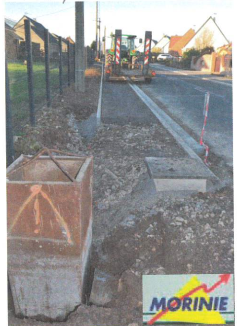
Trottoirs rue de la Place réalisés par l'intercommunalité
