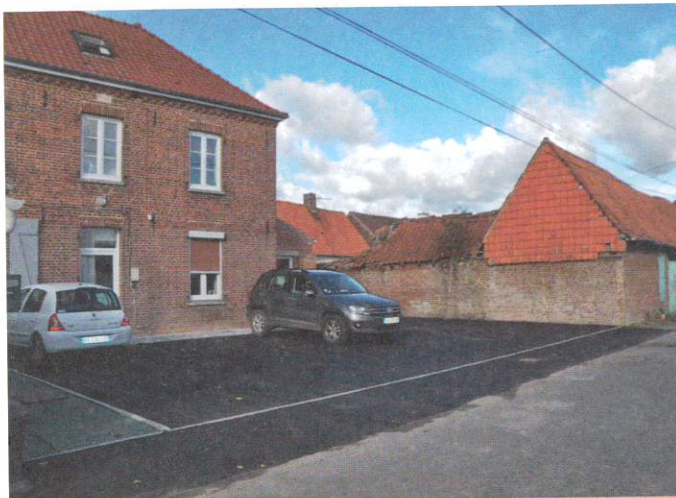
Places de parking pour les logements de l'ancien presbytère de Crecques
