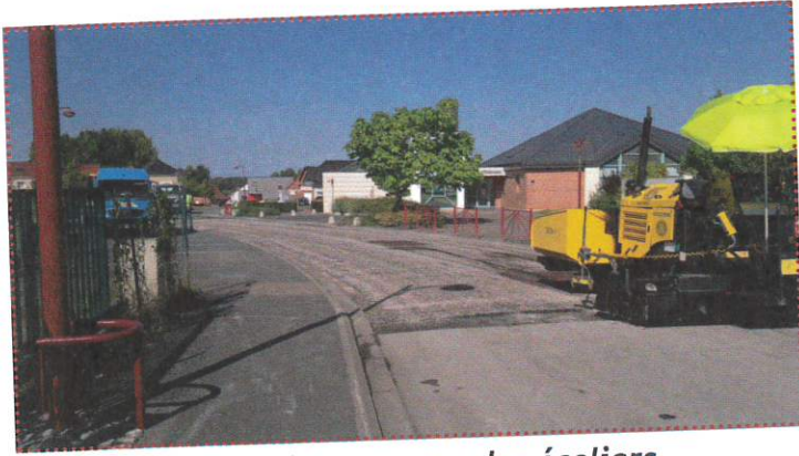
Goudronnage rue des écoliers
