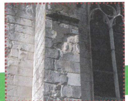
Remplacement des pierres
