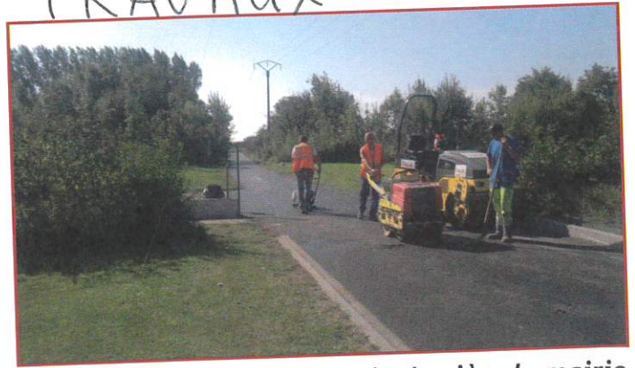
Pose d'enrobés sur le chemin derrière la mairie
