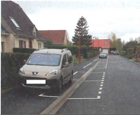
Non respect du traçage au sol
