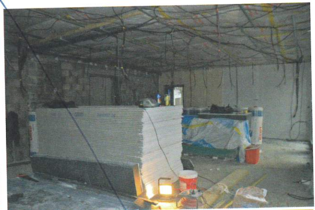
Plâtrerie et câblage électrique
