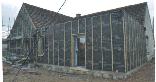
Construction de l'extension
