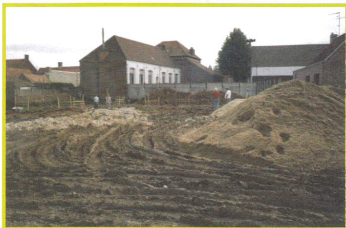
2002 - Début des travaux pour la construction de trois classes
