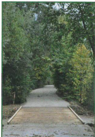
Plateforme à l'entrée et la sortie des eaux
