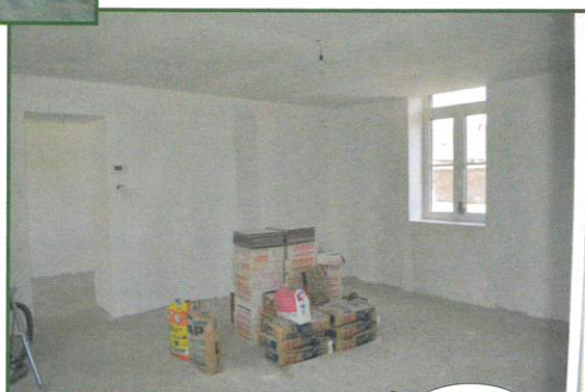
Rénovation d'un des deux logements au presbytère de Crecques
