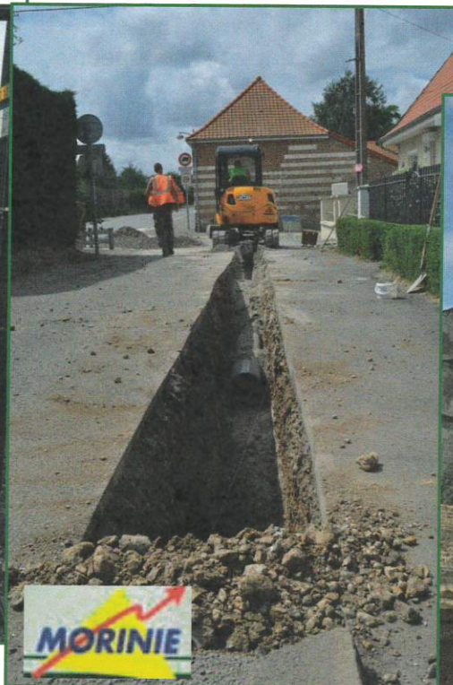
Pose d'un réseau pluvial « Contour de l'Eglise »
