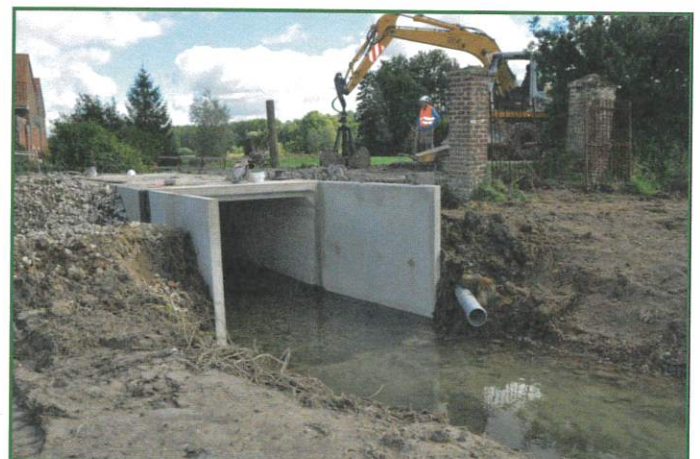
Remplacement du pont « Rue du moulin » par le Conseil Départemental
