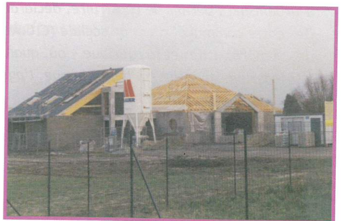
DÉCEMBRE 1999 - Salle du Millénum en cours de construction
