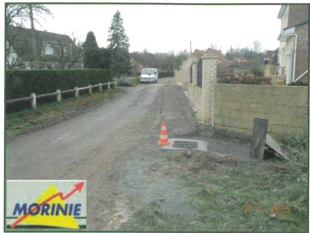
Réseau pluvial rue de la Barre
