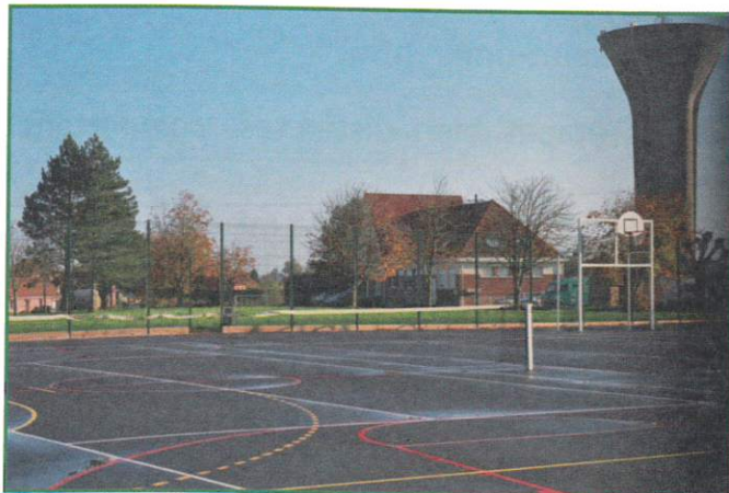
POSE D'EQUIPEMENTS SPORTIFS SUR LE TERRAIN DE JEUX DE LA PLACE DU RIETZ A MARTHES
