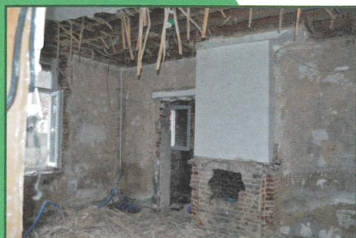
TRAVAUX D'ISOLATION LOGEMENT DU PRESBYTERE DE CRECQUES
