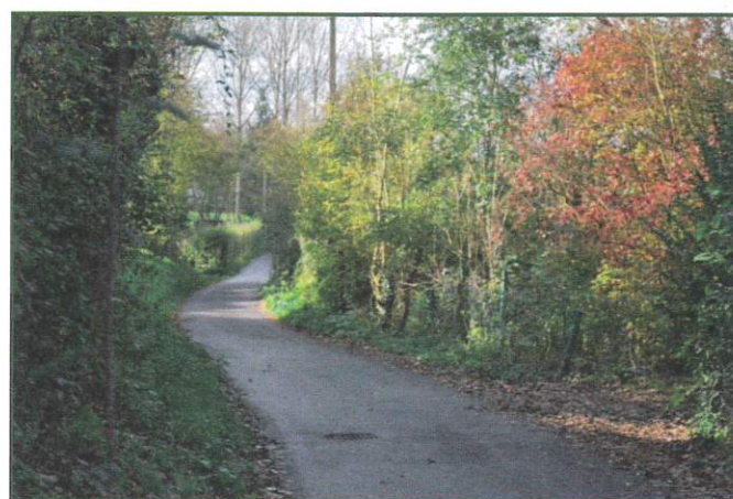
GOUDRONNAGE CHEMIN DES RUELLES
