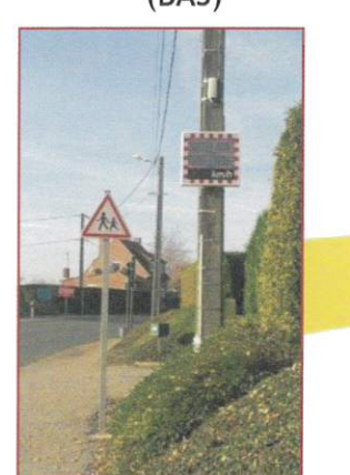
INSTALLATION DE 2 RADARS PÉDAGOGIQUES
