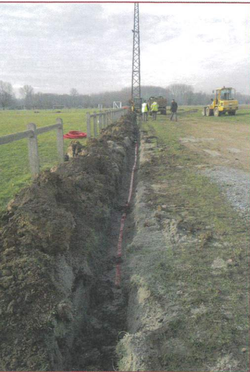
PASSAGE DES FOURREAUX
