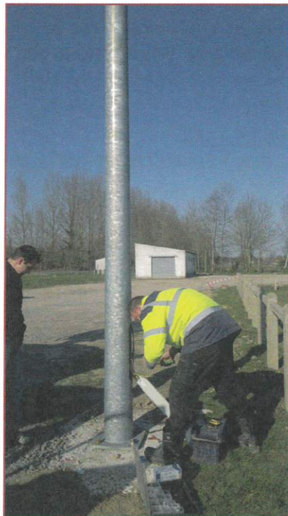
INSTALLATION DES 8 MATS
