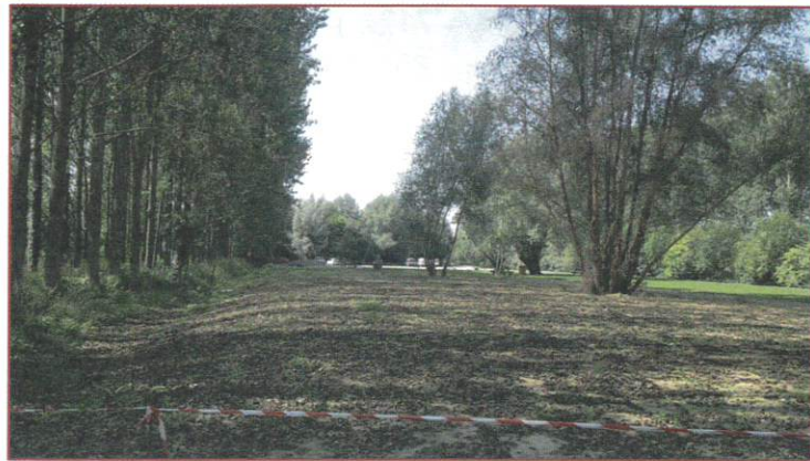
APRES DEMONTAGE ET MISE EN PLACE DES TERRES DE REMBLAI
