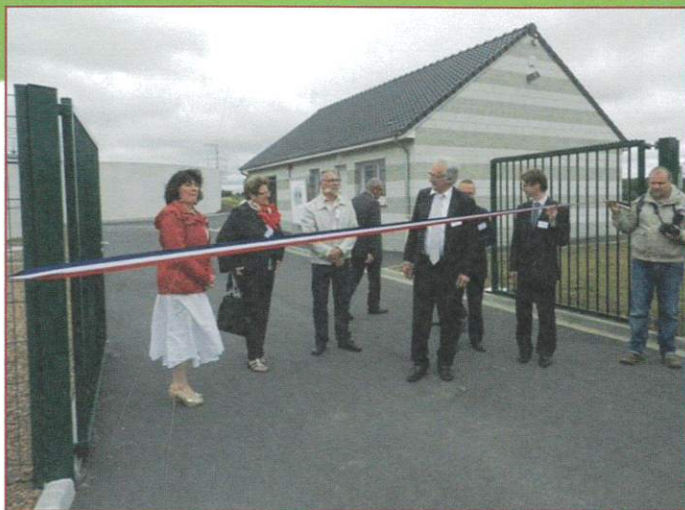
Inauguration et journée portes ouvertes à la nouvelle station d'épuration
