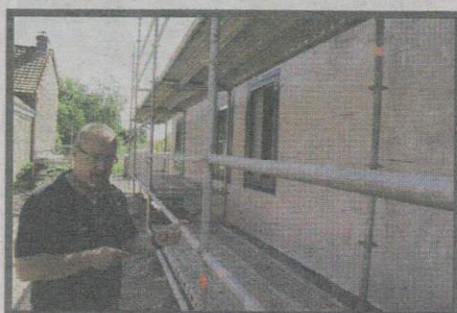
Pour l'extension, reste les parements extérieurs. Les finitions intérieures prendront la suite.
