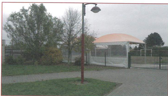
CRÉATION D'UN NOUVEAU PRÉAU À L'ÉCOLE DES TILLEULS
