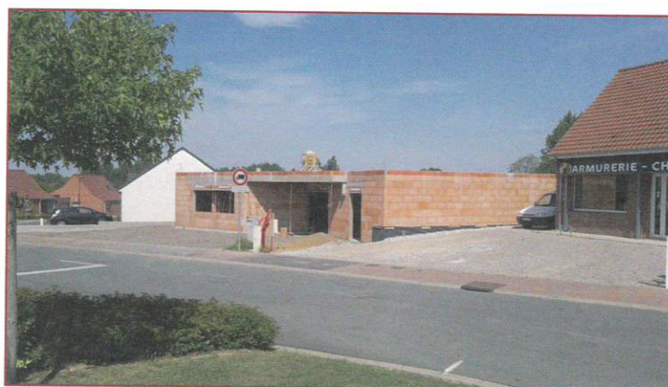
CONSTRUCTION D'UN CABINET DENTAIRE PAR LE DOCTEUR COCQUEMPOT
