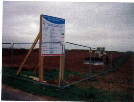
ON DÉCAISSE LE SITE
