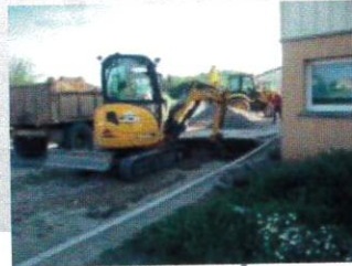
LES TRAVAUX DE VOIRIE
