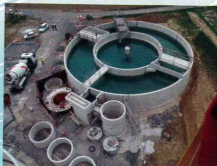
VUE DE LA GRUE DE CHANTIER
