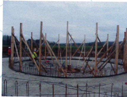
POSE DU SUPPORT BASSIN DÉCANTATION
