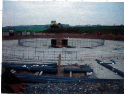
COULAGE DE LA DALLE
