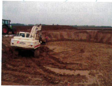
CREUSEMENT DES BASSINS
