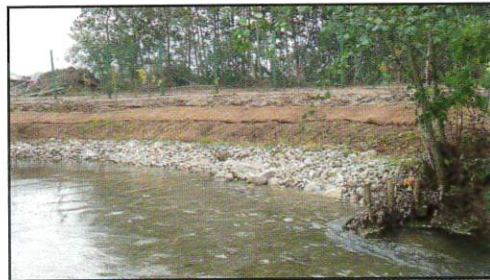
Les berges, avant et après renforcement
