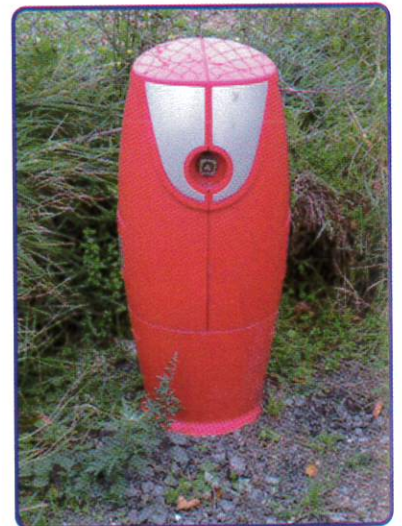
Pose de 9 poteaux incendie par le syndicat des eaux
