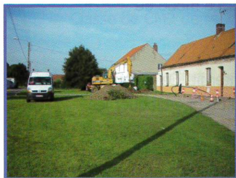
Travaux en eau potable à Marthes
