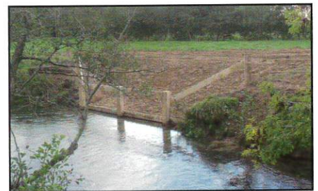
Création d'un abreuvoir
