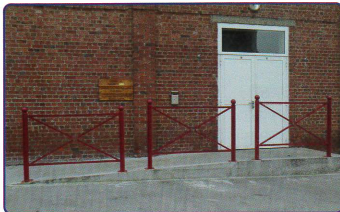
Réalisation d'une rampe d'accès handicapés à la salle paroissiale
