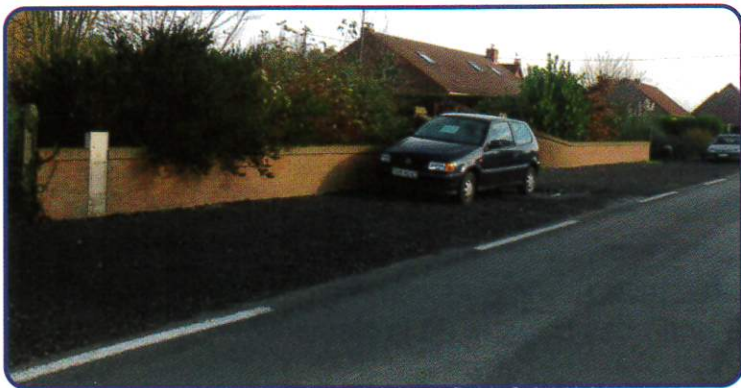
Réalisation d'un réseau pluvial et réfection de l'accotement Grand'rue entre Mametz et Crecques
