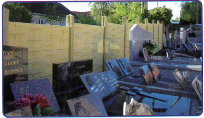
Palissade en béton au cimetière de Marthes
