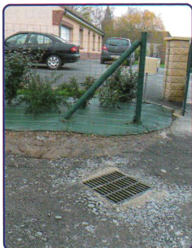
Réalisation d'un réseau pluvial à Marthes, rue des Charbonniers
