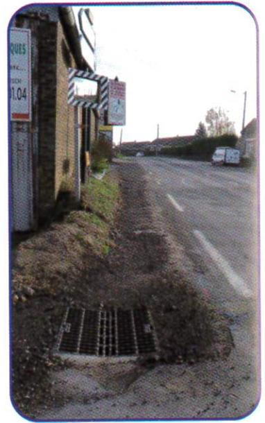
Réalisation d'un réseau pluvial et réfection de l'accotement à l'entrée de Crecques
