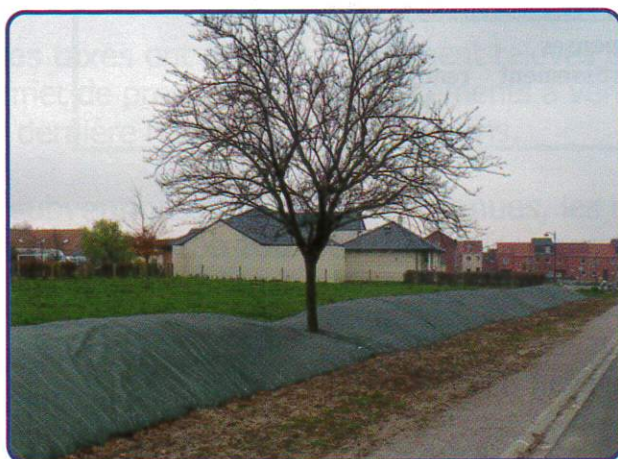
Bâchage de talus pour un futur fleurissement
