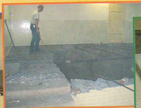
POSE D'UNE DALLE EN HOURDIS
