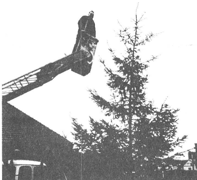
Les électriciens à l'œuvre
