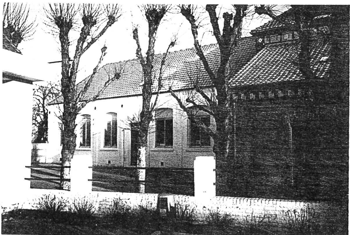
- Réfection du Toit de l'Ecole de Mametz-Centre
