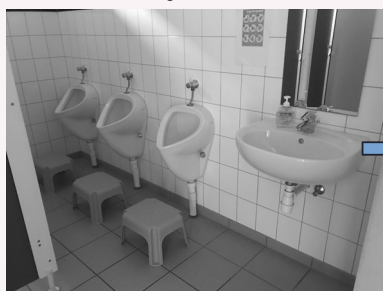
Avant: marches-pieds disposés à la légère car urinoirs installés initialement trop haut pour des écoliers et présentant des risques de chutes et glissades
