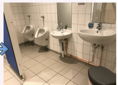
Après: Abaissement des urinoirs et lave-mains pour plus de confort et sécurité
