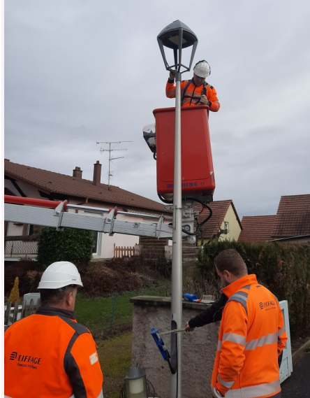
Rénovation de l'éclairage public en LED
