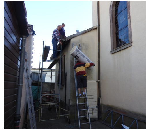
Isolation des combles de la sacristie
