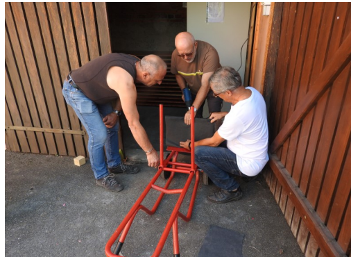
Poursuite des travaux de rénovation de la salle des fêtes, avec pose d'un nouveau carrelage et rénovation de l'espace bar
