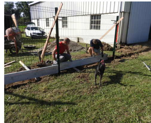
Pose d'une nouvelle clôture autour du futur atelier municipal
