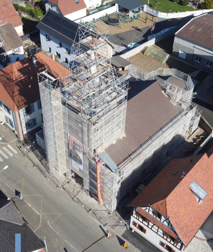
Vue aérienne par drone de l'imposant échafaudage
