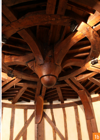
1a. La halle circulaire / 1b. La charpente de la halle circulaire
