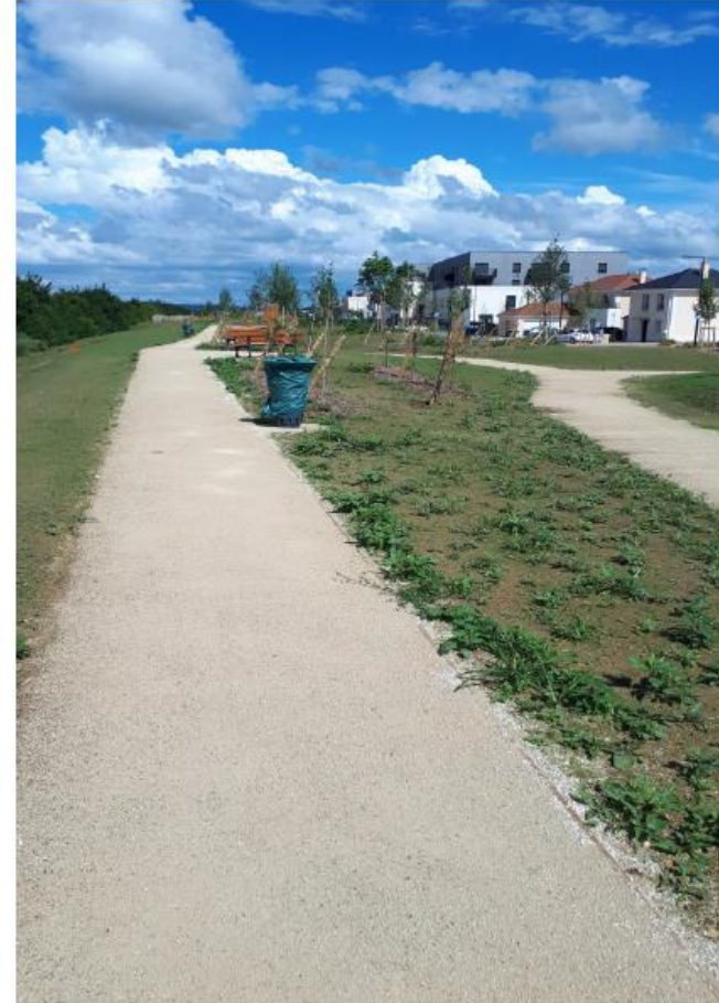
Exemple de chemin stabilisé dans un parc en cours de réalisation
