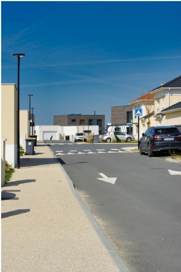
Exemple 1 de voirie en enrobé noir et trottoirs en béton désactivé
