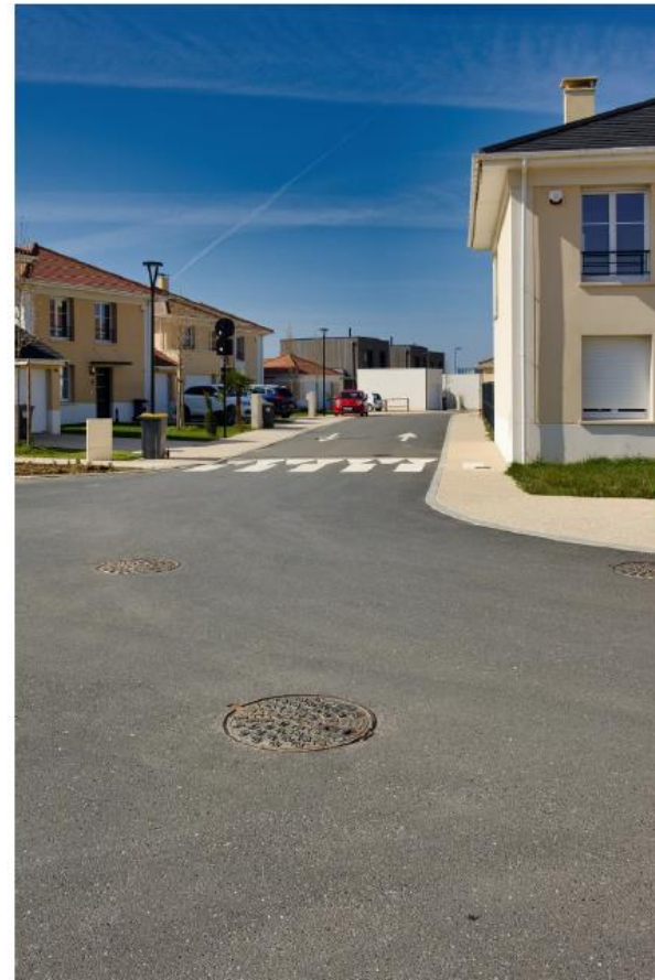
Exemple 2 de voirie en enrobé noir et trottoirs en béton désactivé
