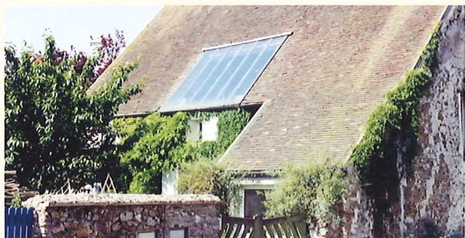
Donner l'illusion d'une verrière grâce à la taille et la disposition des capteurs
