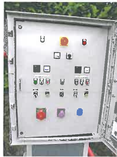
Exemple de réalisation
