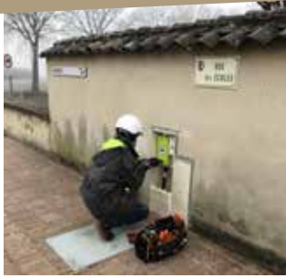
JANVIER: Raccordement au réseau des panneaux photovoltaïques de la salle
