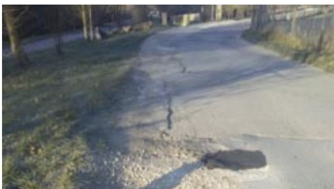
Les accotements de la rue de Côte en partie basse
