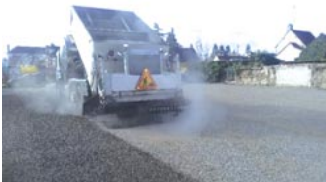
Gravillonnage pour stationnement temporaire
