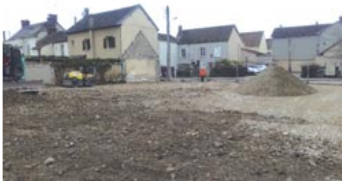
Plateforme en cours de réalisation
