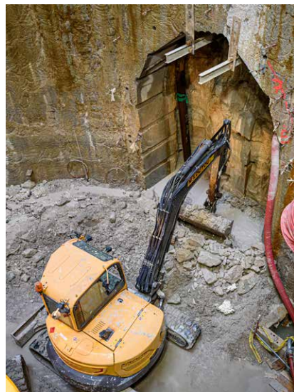
Construction d'un rameau.
