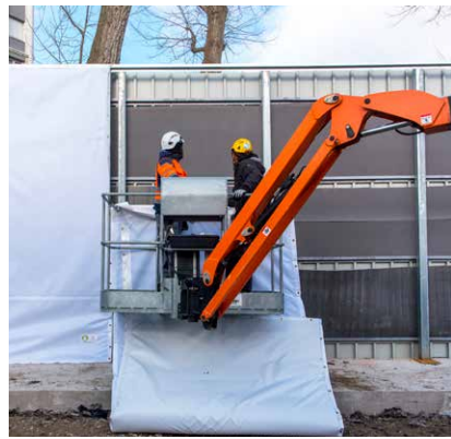
Installation des bâches acoustiques.
