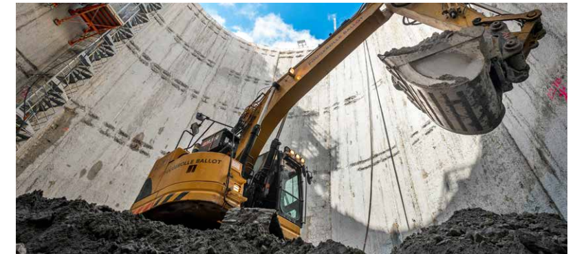
Creusement de la partie souterraine en fond d'ouvrage.
