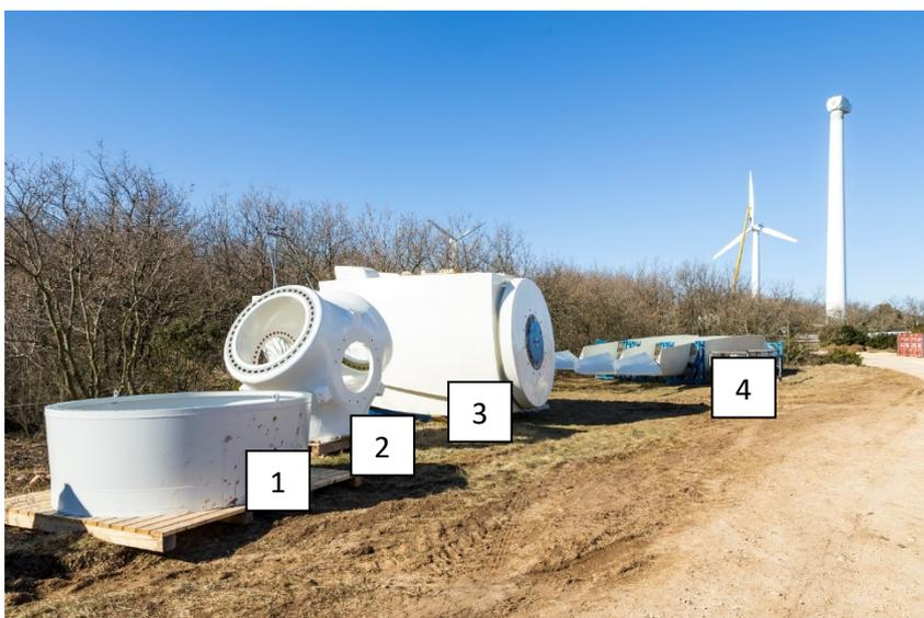
Les nouveaux éléments : 1) une virole conçue spécifiquement pour relier la nouvelle nacelle et le mât conservé, 2) un hub sur lequel se fixent les pales, 3) une nouvelle nacelle (contenant la génératrice) et 4) trois nouvelles pales.
