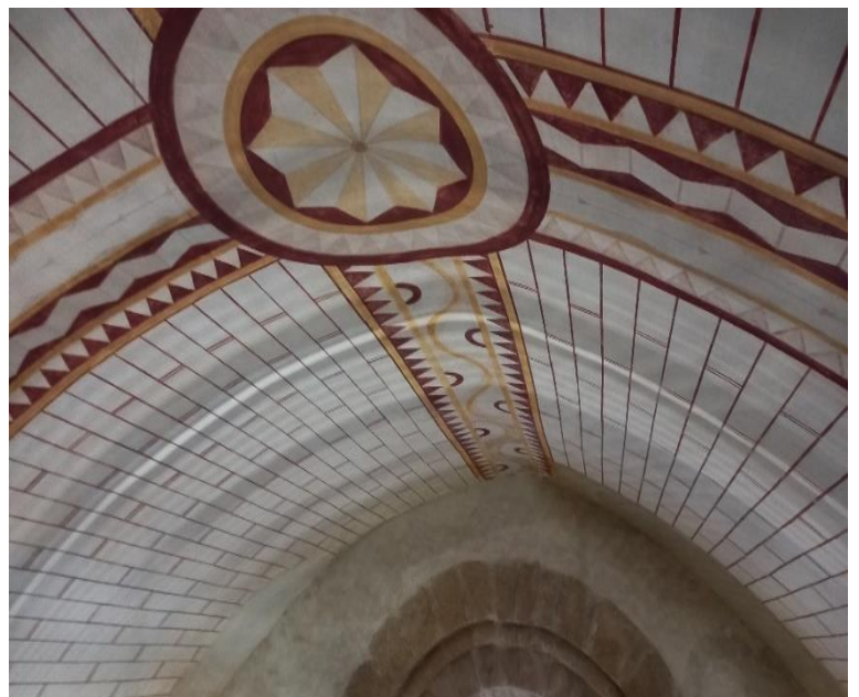
Restauration des décors du transept sud
