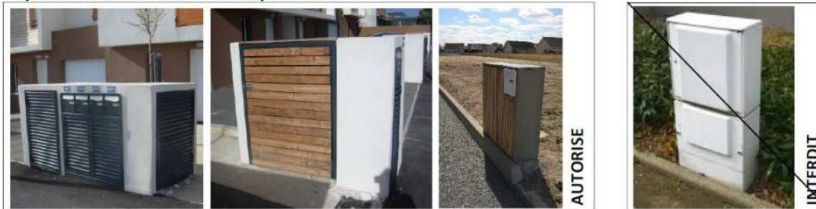
Implantation du coffret technique et BAL
