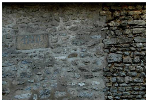
Construction en moellons
