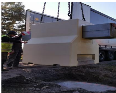
Installation des poutres sécurisant le stade
