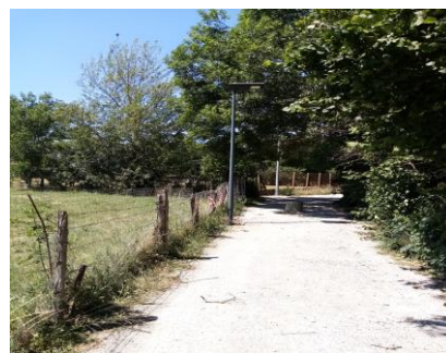
Réfection chemin du stade
