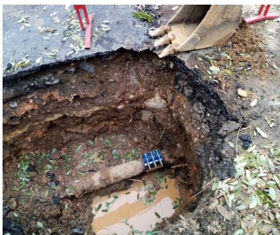
Réparations de fuites réseau eau potable
