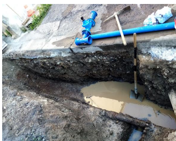
Réparations de fuites réseau eau potable
