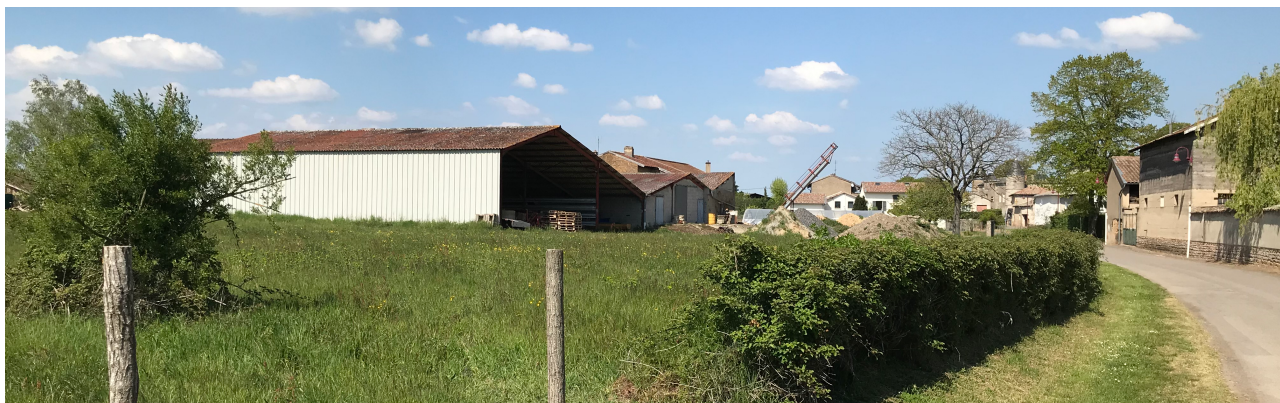
Les hangars métalliques au Sud – Photo Atelier du Triangle
