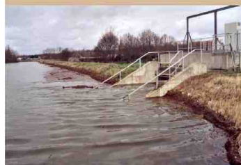
La digue d'Ouroux-sur-Saône (71)
