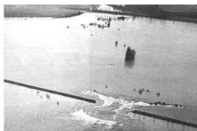
Rupture de la digue de Verjux (cliché Goujon)
