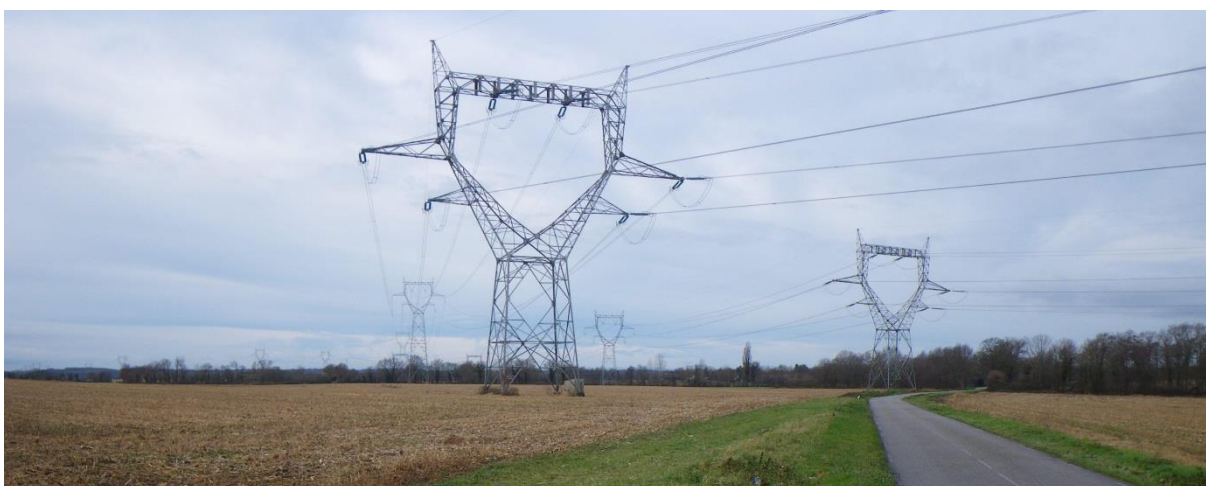
Lignes électriques : élément de fragmentation de l'espace aérien pour les oiseaux (source de percussion ou d'électrocution)
