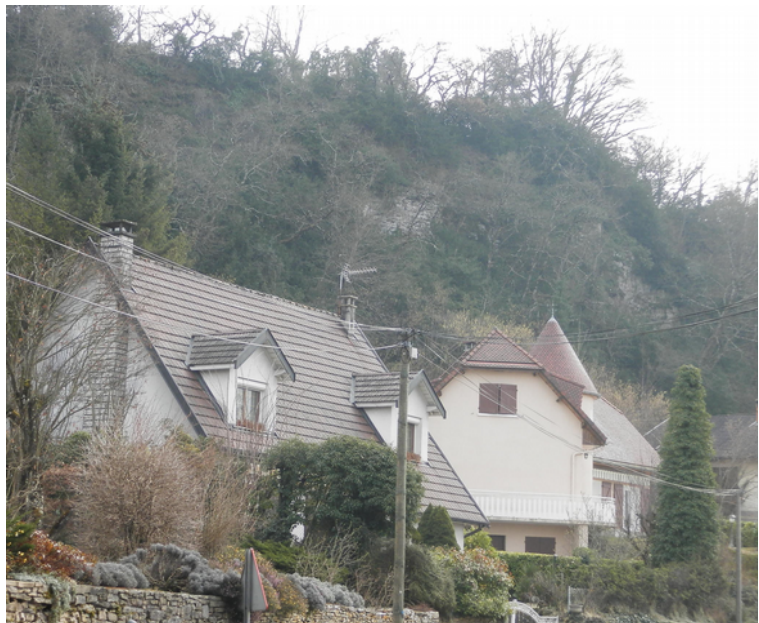
Figure n°10: Falaise au niveau de La Reynière
