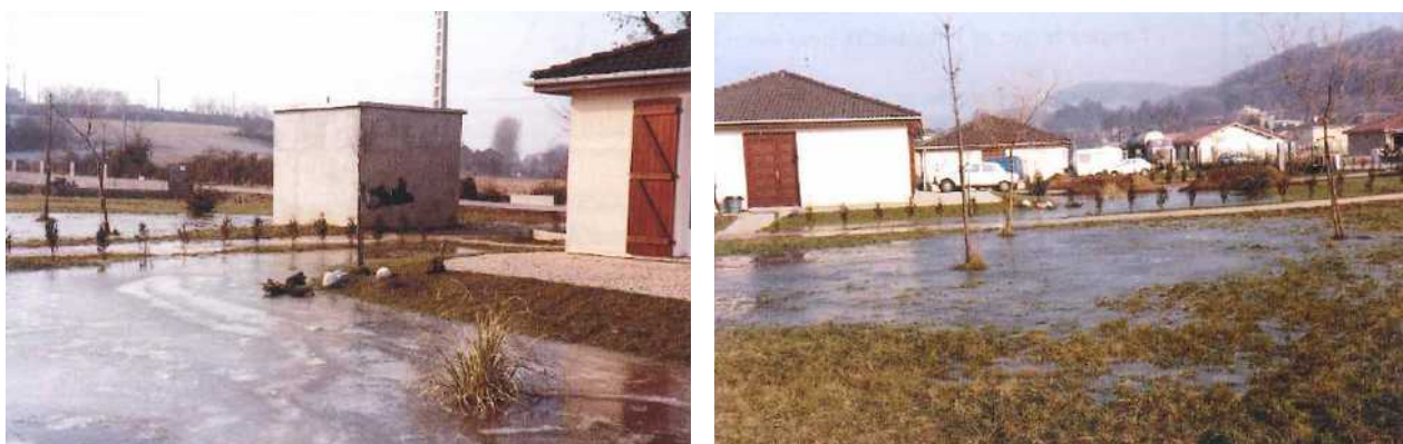
Figure n°4: Inondations dans les lotissements du Château et du Reluisant (1993), source : DICRIM
