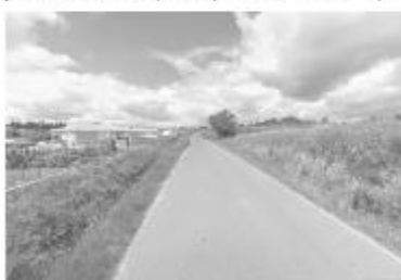
Actuellement : paysage routier sans aménagement qualitatif, le mur s'effondre
