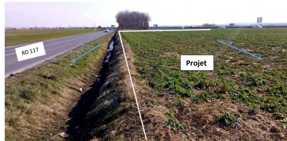
En partie Ouest du projet, une canalisation sous voirie collecte les eaux de ruissellement de la RD 117, qui rejoignent la mare en rive du projet. Celle-ci est connectée au réseau en aval de la route de Corbeil, se poursuivant vers le bourg du Plessis-Pâté.
